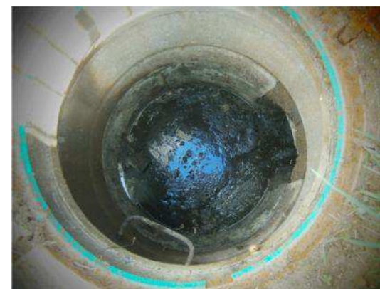
Photo 6 : Eaux Usées rue Hent Daou
